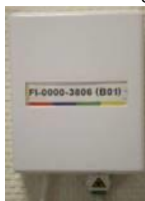
Figure 6 : FTTE passif PM - exemple de PTO
